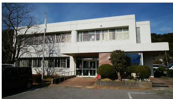
屋上防水工事、外壁改修工事を行う予定の 思井福祉会館
