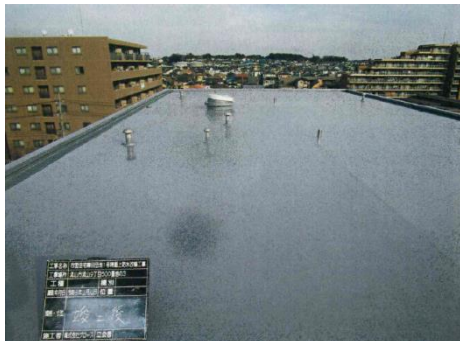
屋上防水工事を実施した柳田団地1号棟
