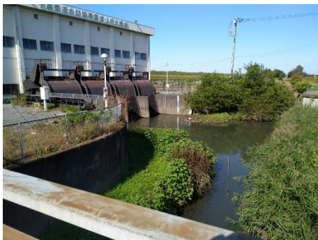
改修を行う予定の流山排水機場
