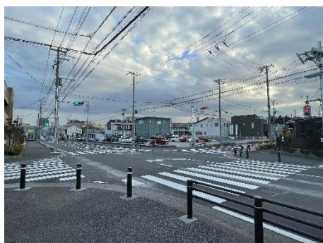
交通の安全を確保するために設置したボールや防護柵
