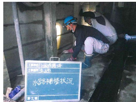
排水路の補修工事の様子
