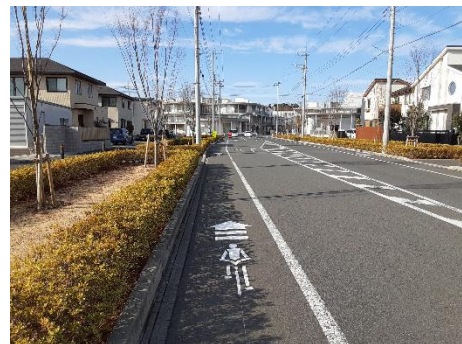
整備が完了した自転車通行空間
