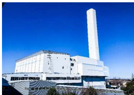
長寿命化工事予定のクリーンセンター焼却施設
