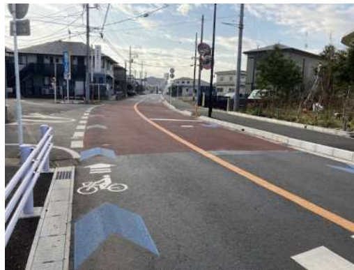
自転車通行空間の整備が完了した東小学校前の道路
