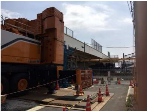
名都借跨線橋の道路拡幅改良
