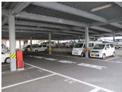
市役所公用車駐車場
