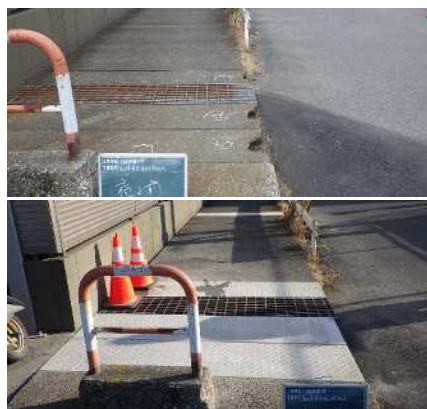
排水路の小破修繕工事 上：施工前 下：施工後
