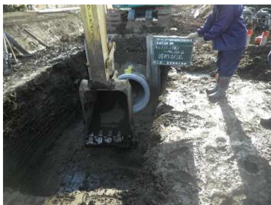
雨水管整備工事の様子
