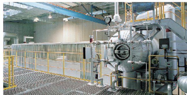
5 廃熱ボイラ・エコノマイザ 廃熱ボイラーはごみを燃焼した際に発生する熱を用いて蒸気を作ります。この蒸気を用いて、施設の給湯、冷暖房や発電を行います。熱を回収することで排ガスの冷却も同時に行っています。
