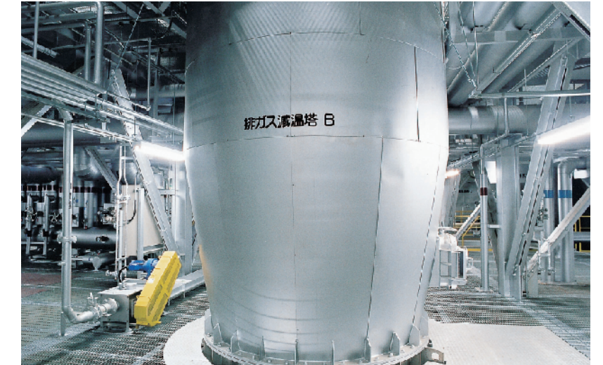
8 排ガス減温塔 排ガスに水噴霧を行うことにより、排ガス温度を減温します。
