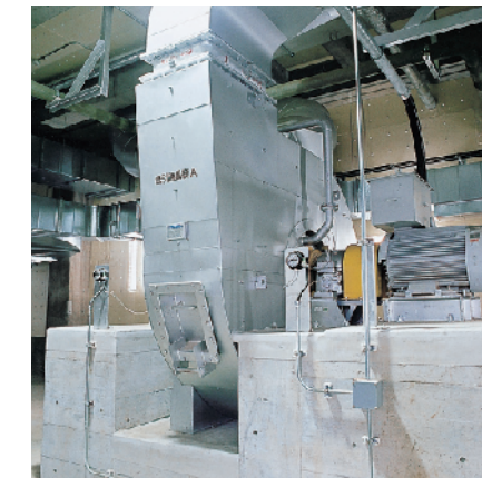
10 誘引通風機 きれいになった排ガスを、煙突へと導く設備です。
